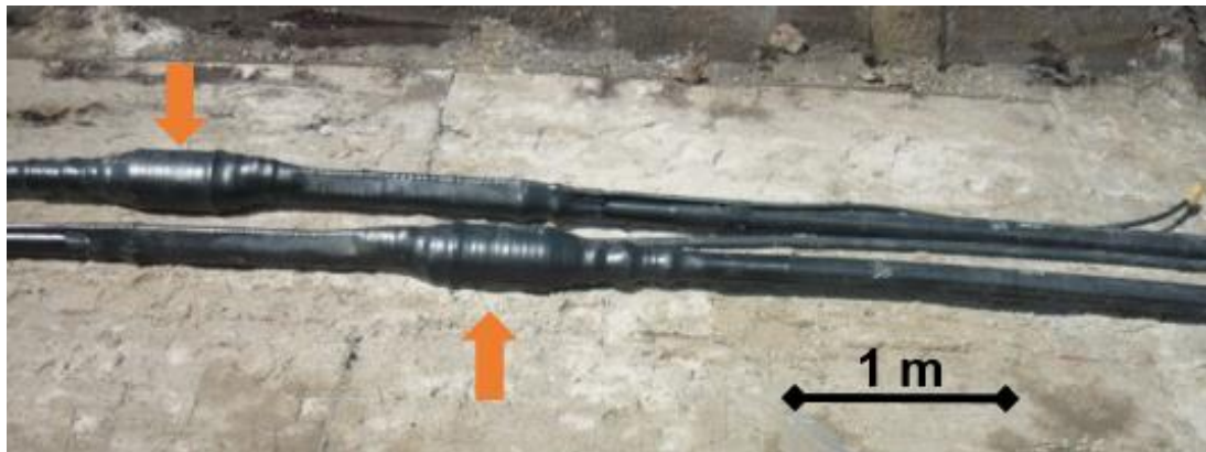
Abbildung 7: Muffen (Pfeilmarkierung) vor Wiederverfüllung des Leitungsgrabens 7
